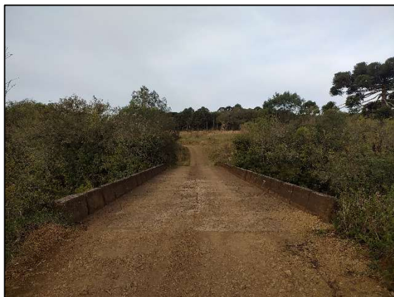
FIGURA 37: PONTE SOBRE O RIO MARRECCAS.
