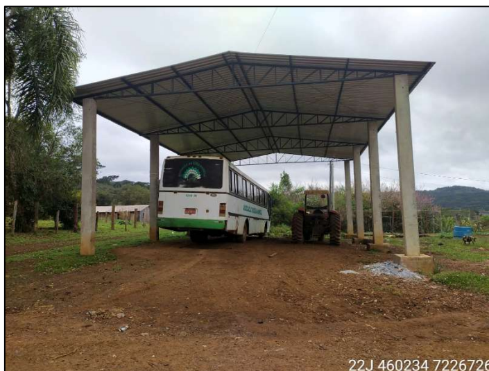
FIGURA 28: GARAGEM DA ASSOCIAÇÃO COMUNITÁRIA MARRECAS, NA ALDEIA SEDE KAINGANG.
