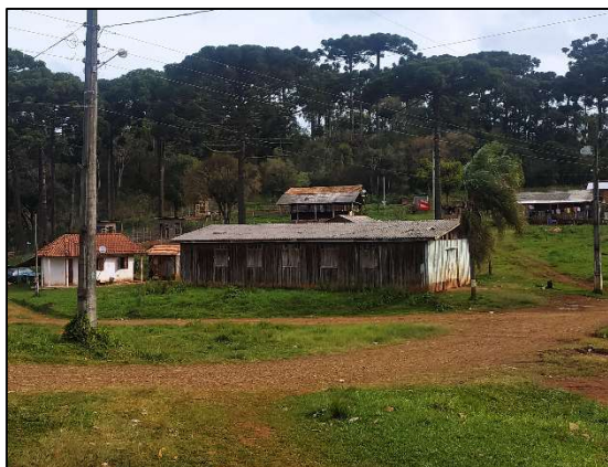
FIGURA 45: SALÃO COMUNITÁRIO ATUAL DA ALDEIA SEDE KAINGANG.
