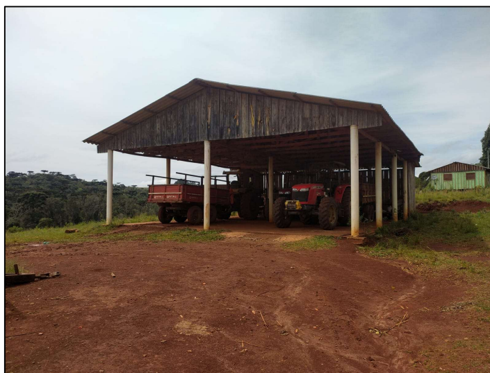
FIGURA 58: GARAGEM DOS TRATORES E EQUIPAMENTOS, NA ALDEIA KOEJU GUARANI.
